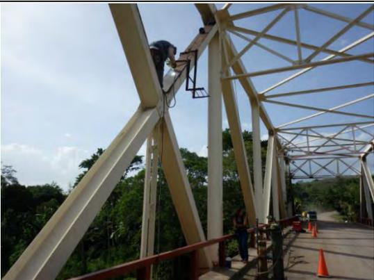
写真-31 トラス斜材補強(2015年10月撮影)
