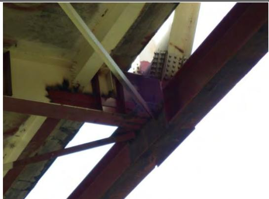
写真-32 トラス格点部補強 (2015年10月撮影)
