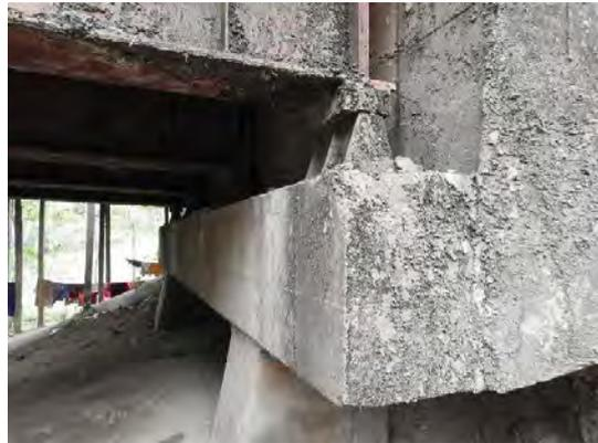
写真-12 橋台部支承及び桁端部状況
