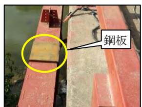
写真-5 鋼板当て板補強
