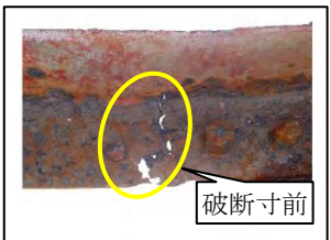
写真-5 破断寸前の鋼材
