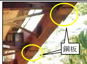
写真-2 鋼板による補強
