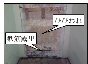
写真-9 下床版の劣化・損傷
