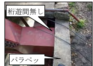
写真-8 桁遊間の確保無し
