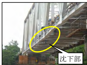
写真-7 最大 22cm の沈下
