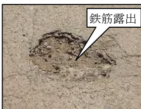
写真-5 舗装の鉄筋露出
