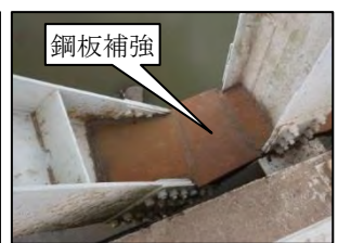
写真-4 鋼板による補強
