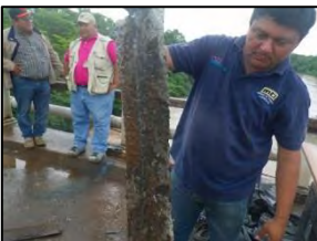
写真-6 腐食し、落下した鋼材
