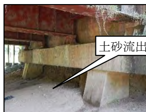
写真-7 裏込土砂流出(A1)
