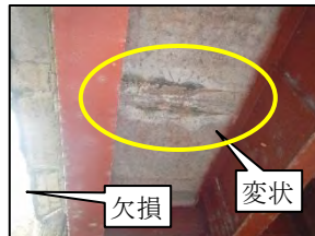
写真-2 床版下面の変状
