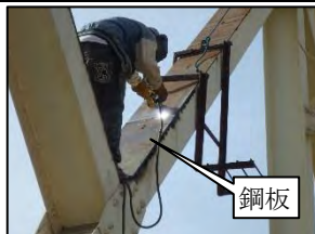
写真-3 鋼板による補強
