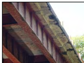
写真-3 床版張出し部の劣化
