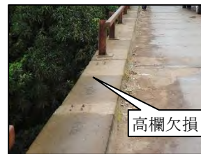
写真-6 欠損している高欄
