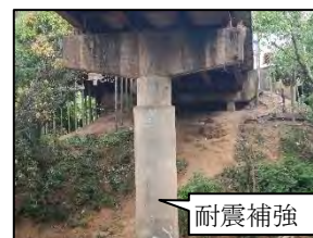
写真-10 耐震補強された橋脚
