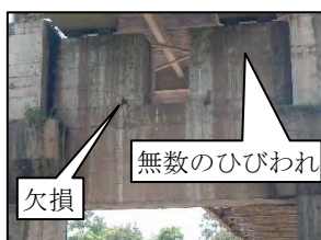
写真-11 劣化の著しい橋脚
