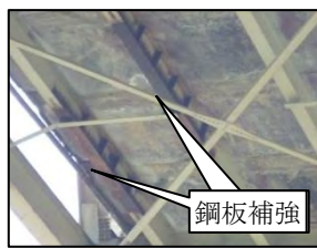
写真-2 鋼板により補強
