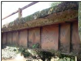
写真-1 劣化が見られる主桁
