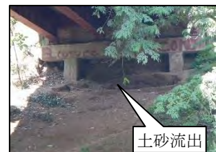
写真-8 裏込土砂流出(A2)
