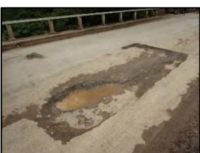
写真-10 損傷の著しい舗装
