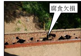
写真-4 高欄上部の腐食欠損
