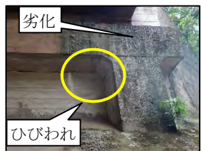
写真-9 劣化の著しい橋脚
