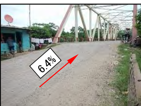
写真-10 縦断のきつい取付道路
