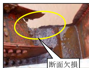
写真-3 滞水により腐食した鋼材
