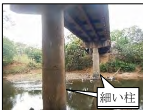
写真-9 耐震性の劣る橋脚
