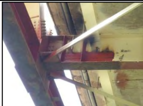
写真-1 腐食の著しい鋼部材
