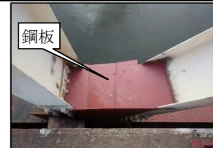
写真-4 鋼板による補強
