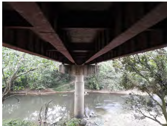
写真-14 河川内橋脚状況
