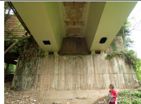
写真-8 橋台および側径間鋼箱桁状況
