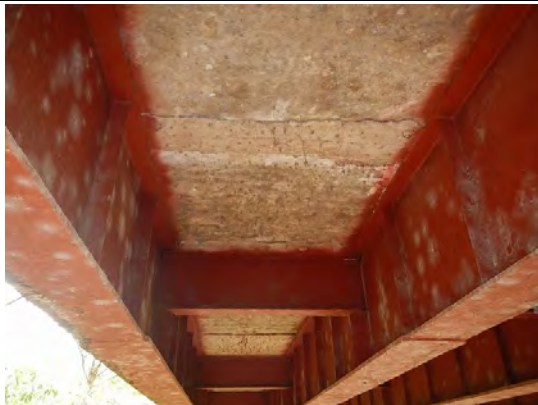
写真-11 床版下面状況
