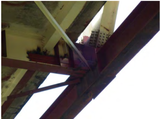
写真-32 トラス格点部補強 (2015年10月撮影)
