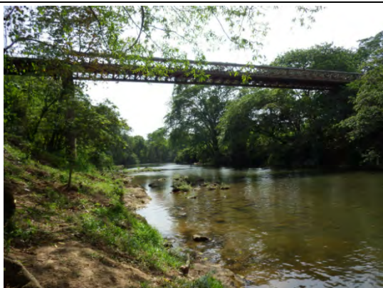
写真-17 既設橋 全景
