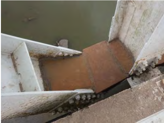
写真-5 トラス格点部補強状況 (鋼板補強)
