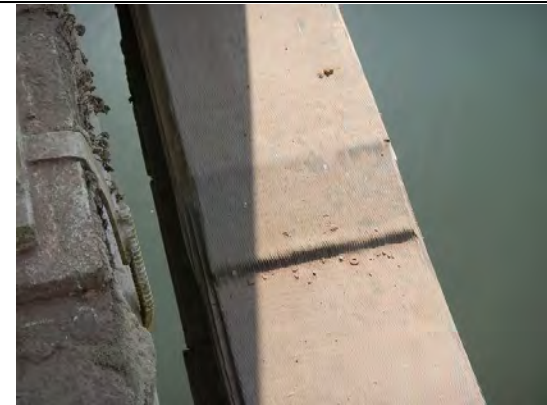
写真-4 トラス材補強状況 (炭素繊維補強)
