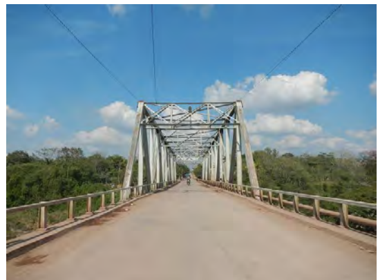
写真-2 既設橋 橋面状況
