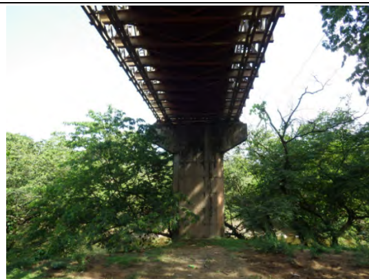
写真-22 橋脚状況
