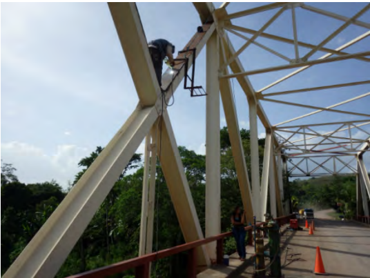
写真-31 トラス斜材補強(2015年10月撮影)
