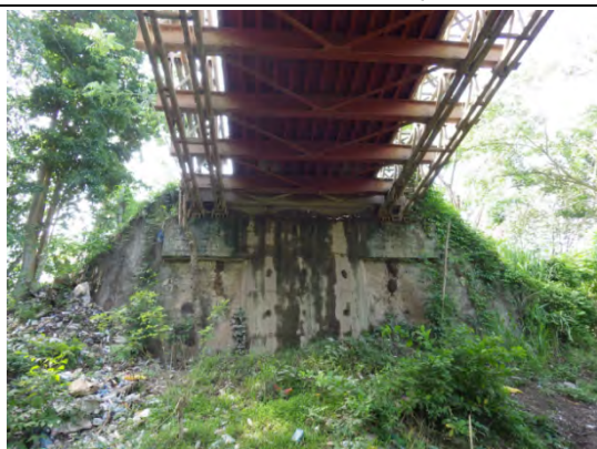
写真-23 橋台状況
