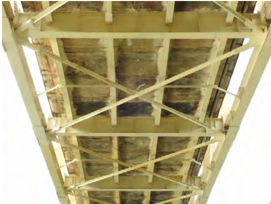
写真-27 床版下面状況
