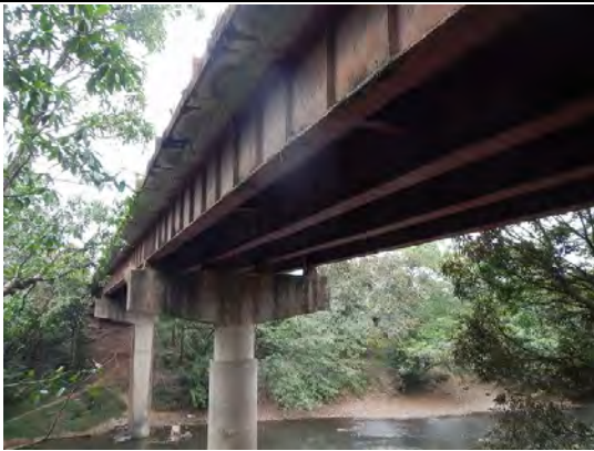
写真-9 既設橋 全景
