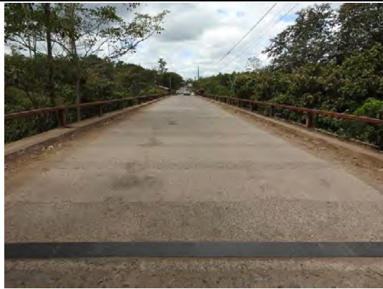
写真-10 既設橋 橋面状況
