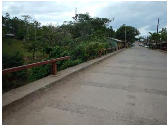
写真-13 高欄損傷状況
