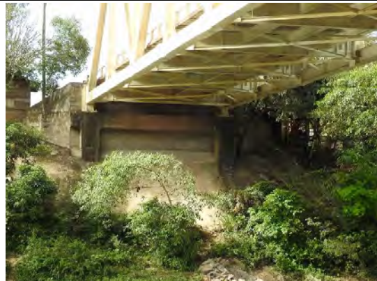
写真-28 橋台状況
