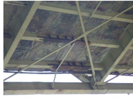
写真-6 トラス縦桁補強状況
