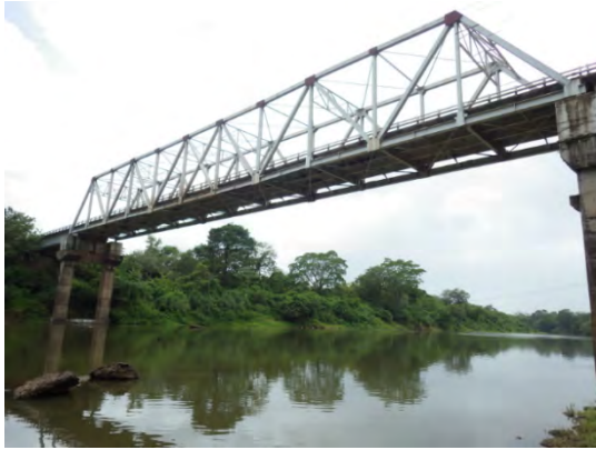
写真-1 既設橋 全景
