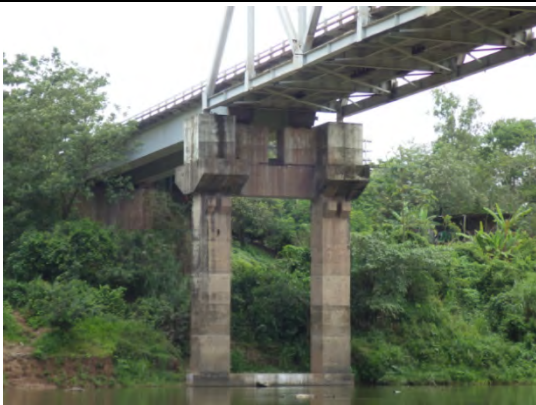
写真-7 河川内橋脚状況
