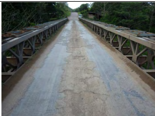
写真-19 橋面舗装状況
