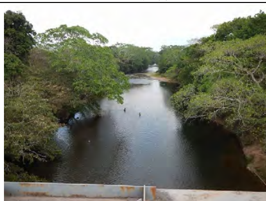
写真-24 河川状況
