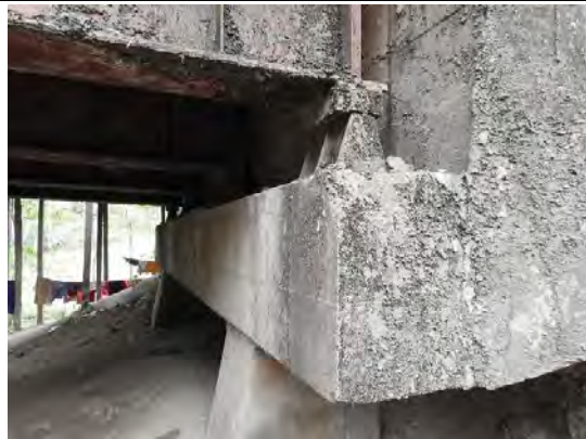
写真-12 橋台部支承および桁端部状況
