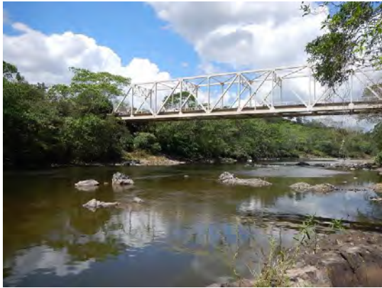
写真-25 既設橋 全景
