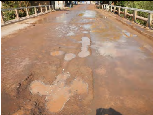
写真-3 橋面舗装損傷状況
