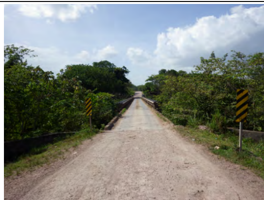
写真-18 既設橋 橋面状況
