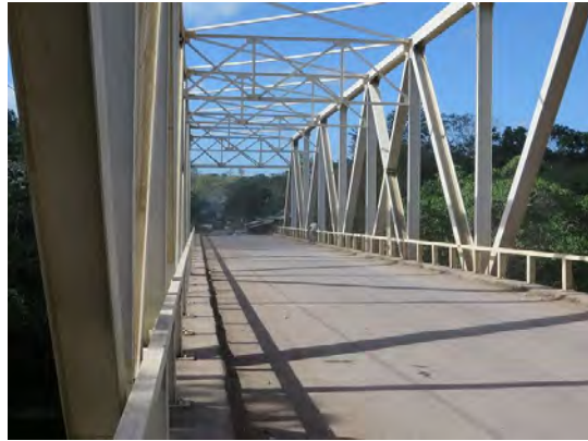
写真-26 既存橋 橋面状況
