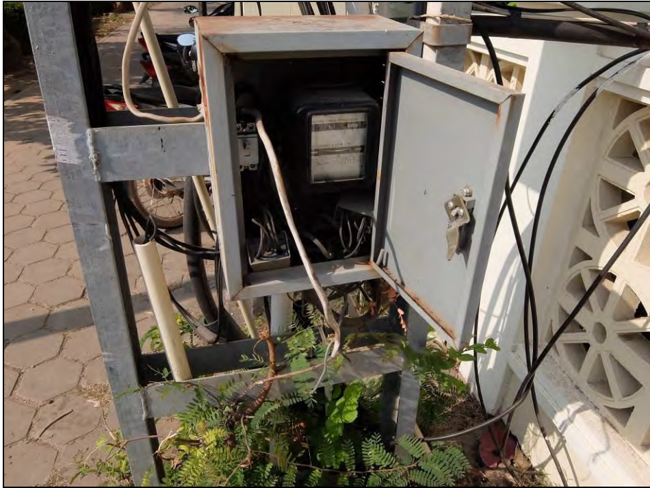
写真 4-2 派出所への電源ケーブルが引きちぎられた様子
