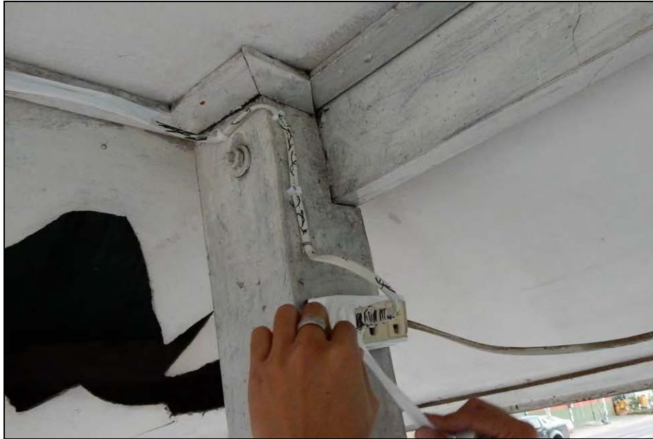
写真 4-1 配線ケーブルを汚すことによる盗難対策
