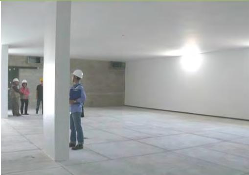
写真-5：発掘した陶器を保管するための倉庫。コンクリート打ちっばなしの壁・床。排気管や窓を取り付ければ完成する状態。
