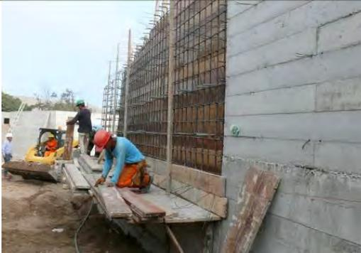
写真-3：壁のコンクリート流し込み用の型枠を設置している様子。
