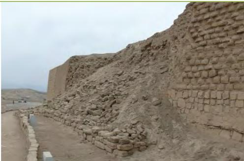
写真-13：過去の地震で崩れた遺跡の壁。他にも環境影響や地震が原因で崩れている壁が散見された。
