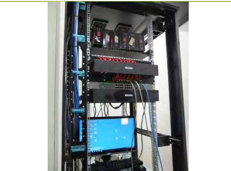
写真-6: 番組データ保管用サーバー。
