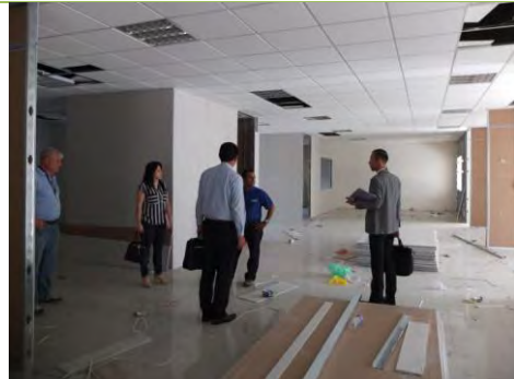
写真-12:現在内装工事中の 2F 部分。左手奥の部屋が番組ソフト保管室。空調設備を伴う温湿度管理可能な部屋となる予定。
