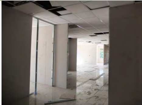
写真-11:現在内装工事中の 2F 部分。工事完了まであと 2 ヶ月ほどかかる見込み。
