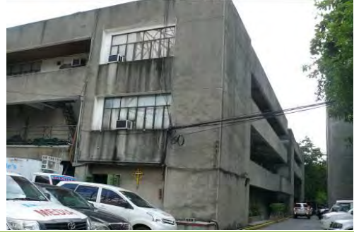
写真-2: 2 つある PTNI 建物の一つ。内装はすでに改修工事が始まっており 2015 年 12 月に完了する予定。
