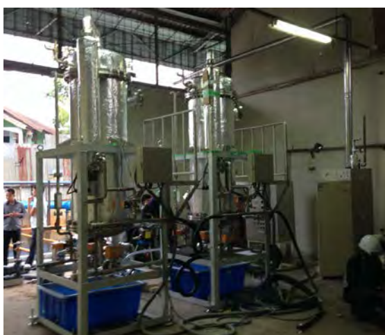
図 3.2 機材の据え付け
