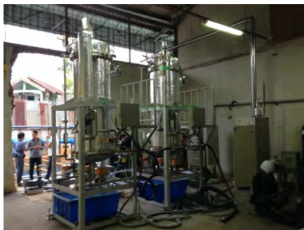
Grand Textile 社の敷地内に据え付け直後の設備
