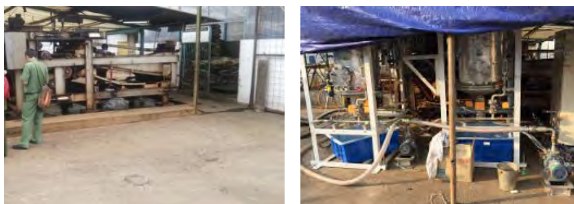
図 3.8 設置前（左）及び据え付け後の機材（右）
