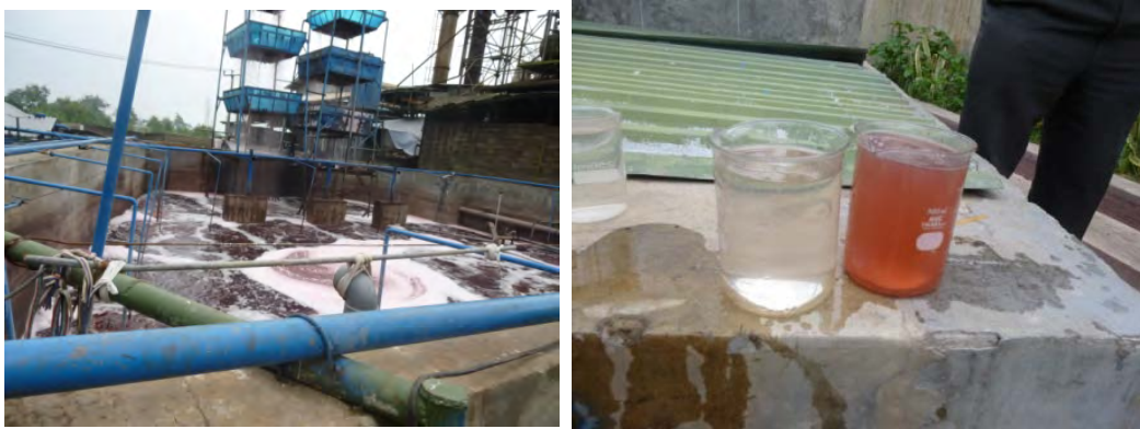
図 3.33 曝気槽（左）及び処理水・原水（右）
