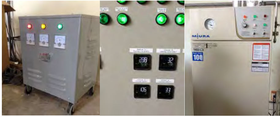
図 3.3 トランス（写真左）の試運転の様子と制御盤（写真中）の電源供給の様子、及びボイラー（写真右）の試運転の様子
