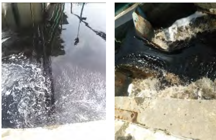
図 3.10 放流槽の様子
