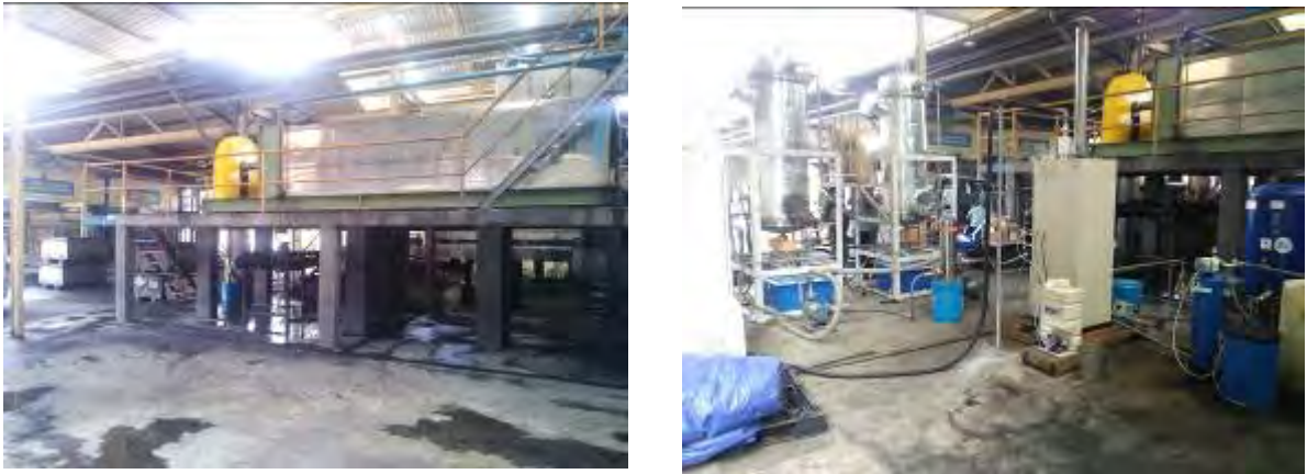
図 3.12 設置前（左）及び据え付け後の機材（右）
