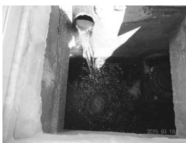
写真 ENSP 既存排水枳の状況
