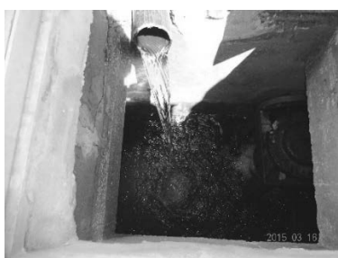
写真 ENSP 既存排水枡の状況
