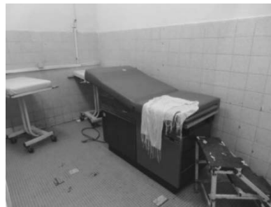
・国立中央病院-2 分娩室の分娩台（電動式）、踏み台と新生児用ベッド。表面の傷み具合を含め全体に老朽化が目立つ。
