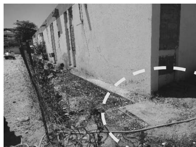
写真 ENSP サイトに近い国立中央病院側の排水枡の位置
