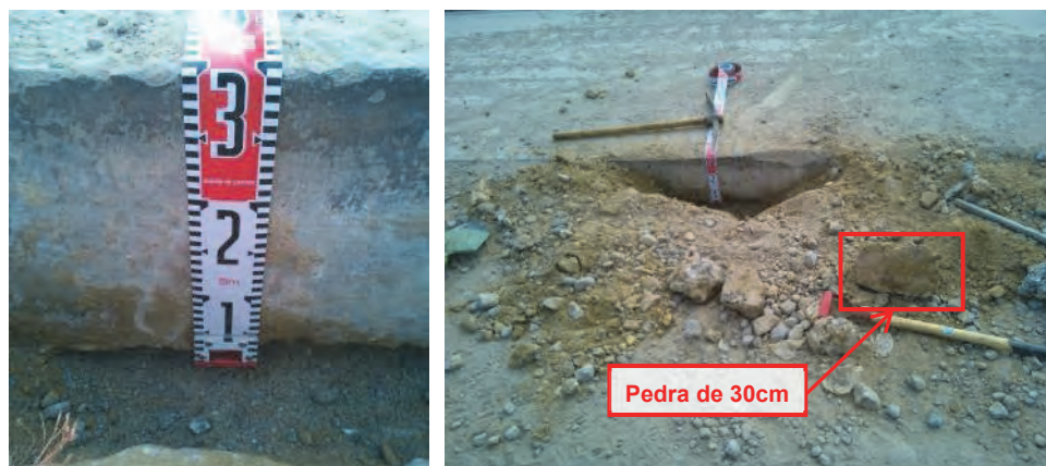
Figura 3.3 Verificação da Espessura do Pavimento do Cais ( t = 30 cm)
