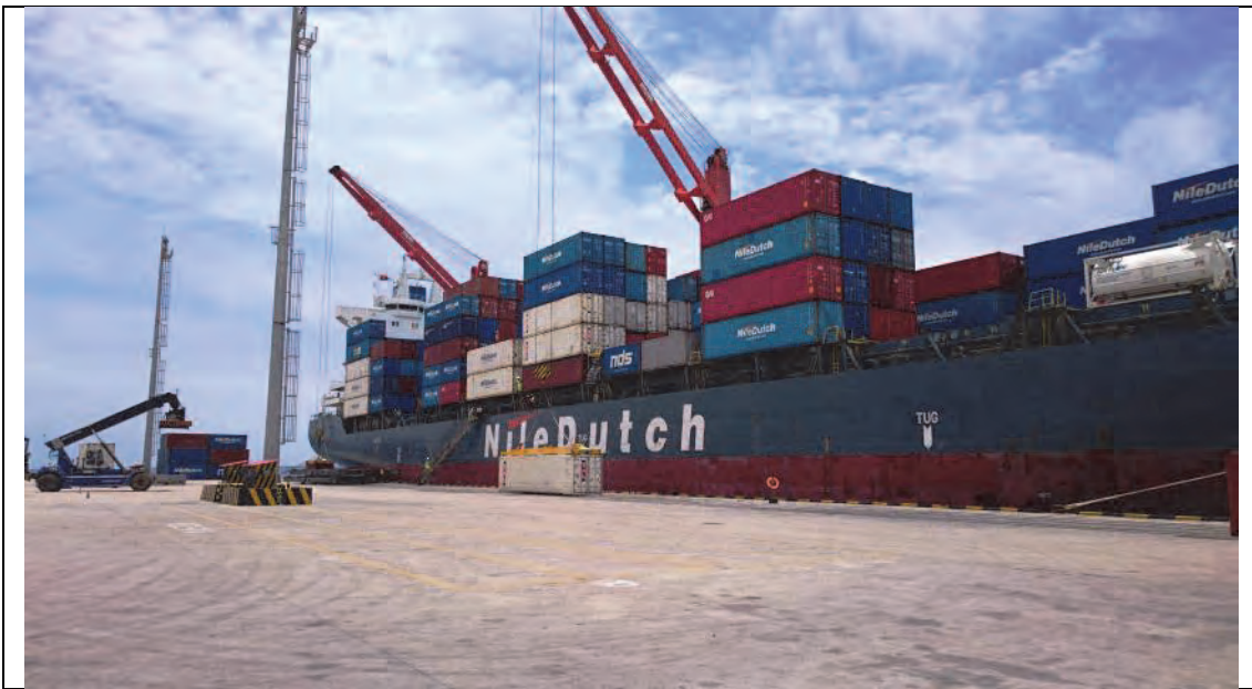
Situação Corrente-7 Utilização do Zona 3A do Porto do Namibe (equipamentado pelo projecto anterior de Cooperação Financeira Não-Reembolsável)
