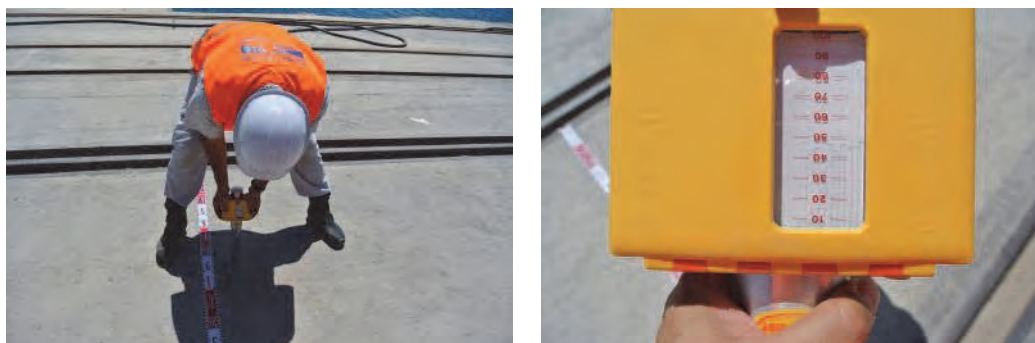
Figura 3.2 Medição da Resistência do Betão
