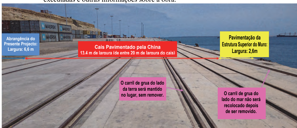
Figura 3.1 Situação do Pavimento do Cais
