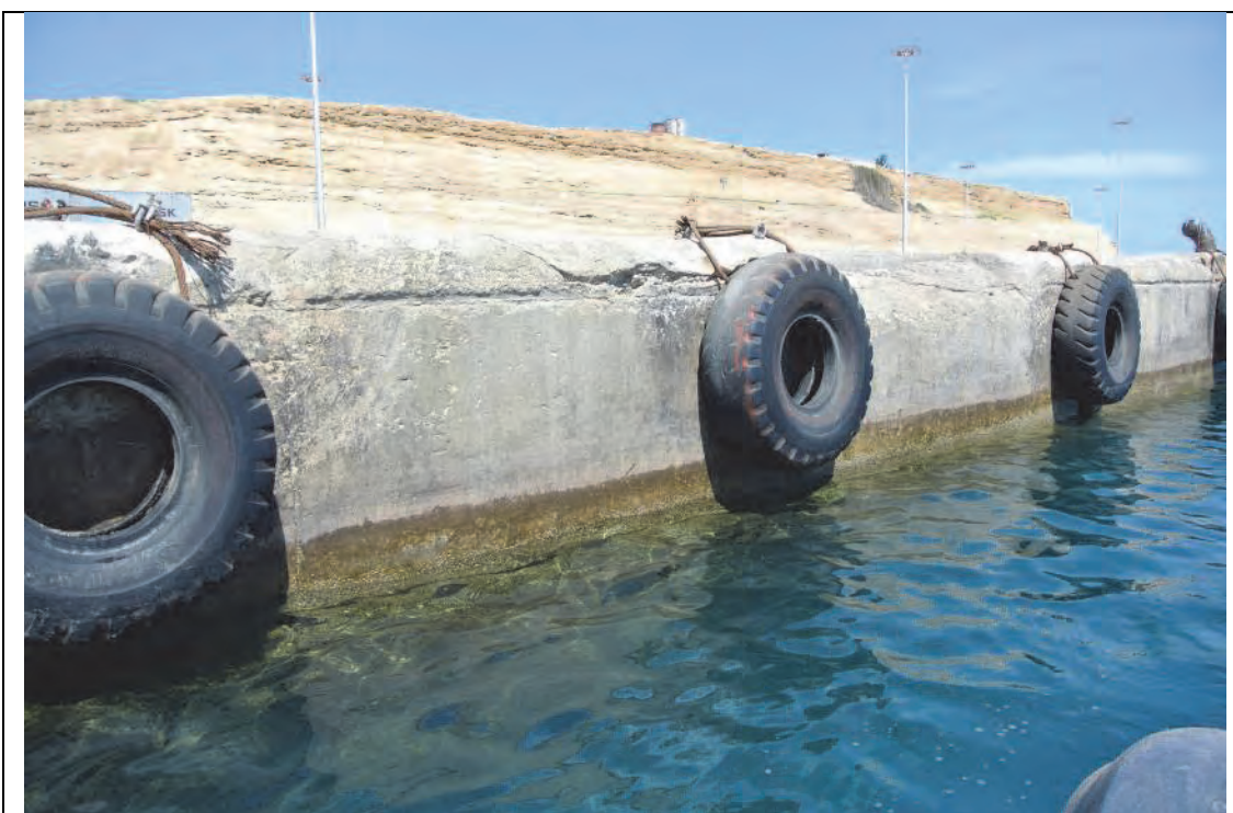
Situação Corrente-2 Situação da Estrutura Superior do Muro e Defensas da Zona 3B (vista do lado do mar)
