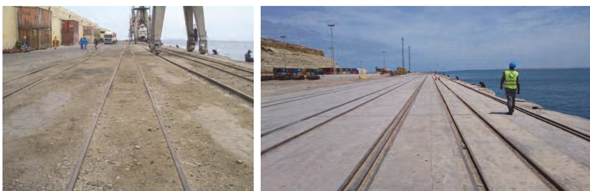
Figura 2.6 Condições do Cais (Esquerda: 2005; Direita: 2016)
