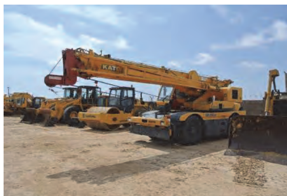
Parque de Maquinaria de Obra da CSN (Namibe)
