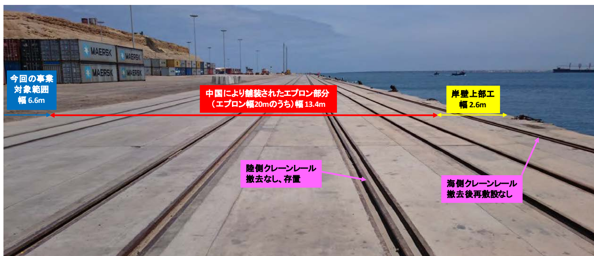
図 3.1 エプロンの舗装状況
