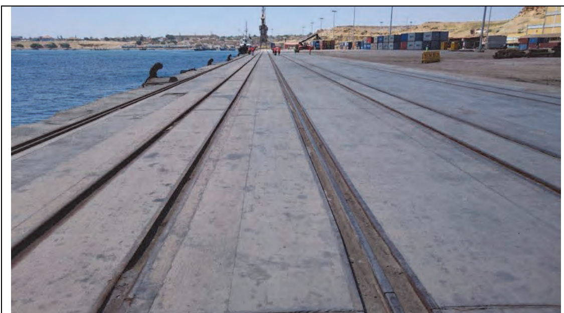
現況写真-4 ナミベ港 3B 岸壁エプロン舗装現況（3A 岸壁側より撮影） 中国による軌道敷設、エプロン舗装
