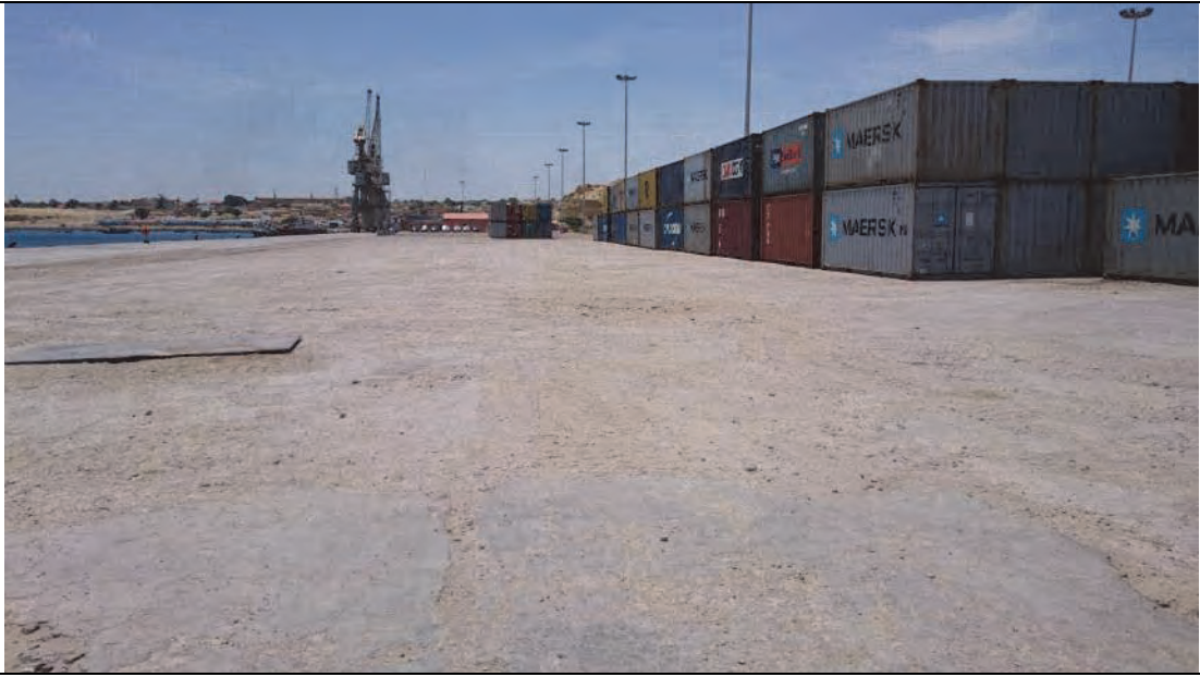
現況写真-5 ナミベ港 3B 岸壁ヤード現況 未舗装、凸凹あり、陥没箇所は鉄板にて補強
