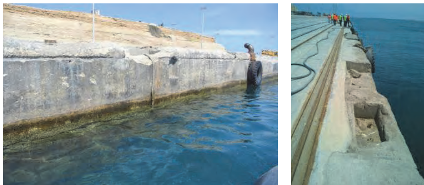
図 2.3 3B 岸壁上部工の状況
