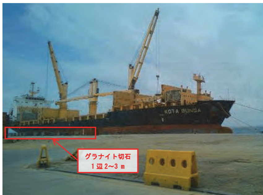
図 3.4 グラナイト切石の仮置状況
