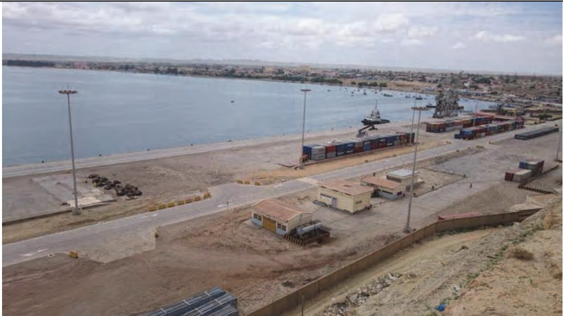
現況写真-1 ナミベ港 3B 岸壁全景
