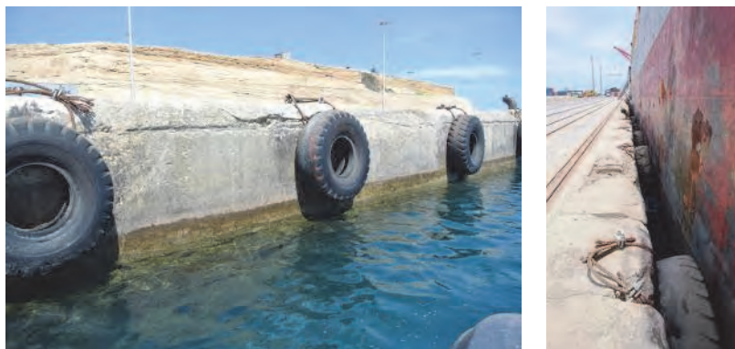
図 2.4 3B 岸壁 防舷材現況
