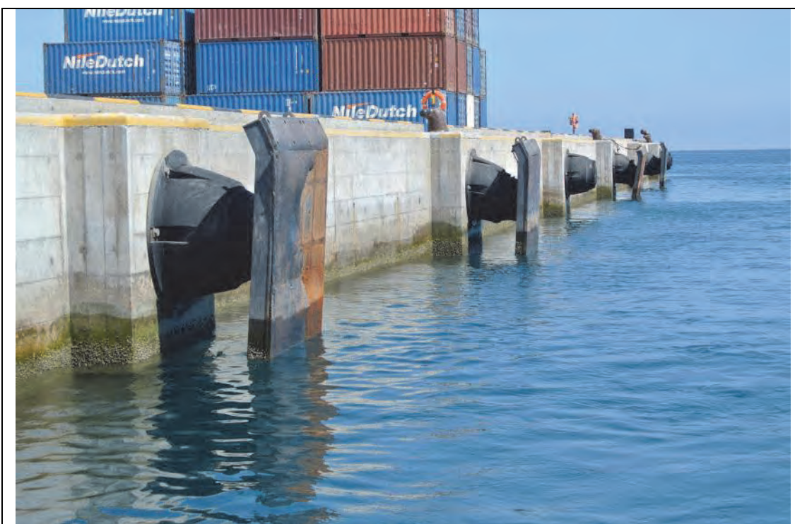
現況写真-8 ナミベ港 3A 岸壁（前回無償事業）現況 防舷材破損状況
