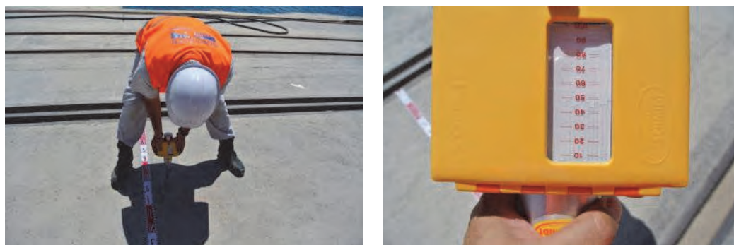
図 3.2 コンクリート強度測定状況
