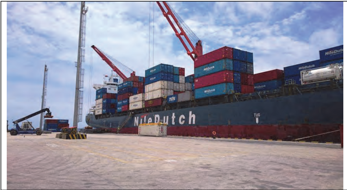
現況写真-7 ナミベ港 3A 岸壁（前回無償事業）利用状況 コンテナ荷役状況
