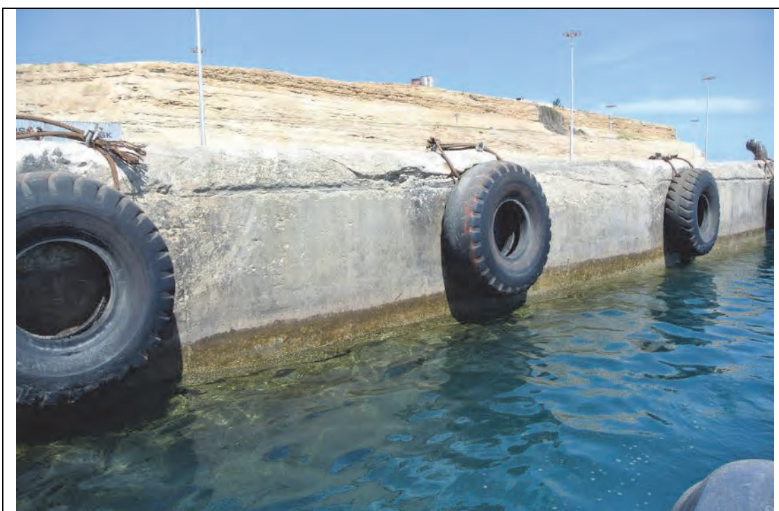
現況写真-2 ナミベ港 3B 岸壁上部工、防舷材現況（海側より）
