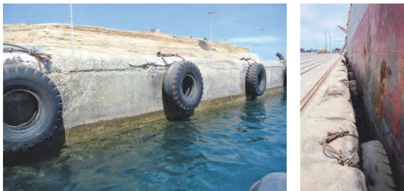
図 2.4 3B 岸壁 防舷材現況
