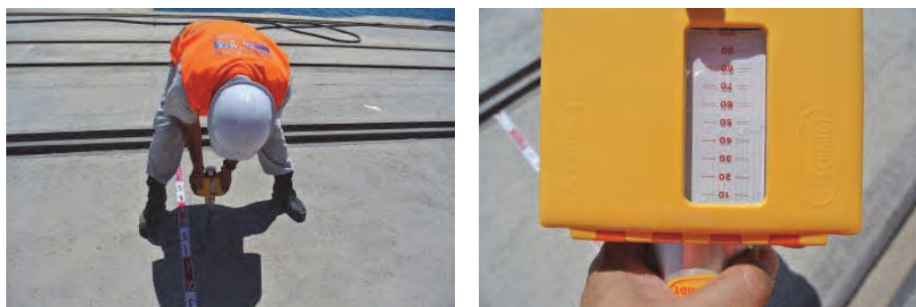
図 3.2 コンクリート強度測定状況
