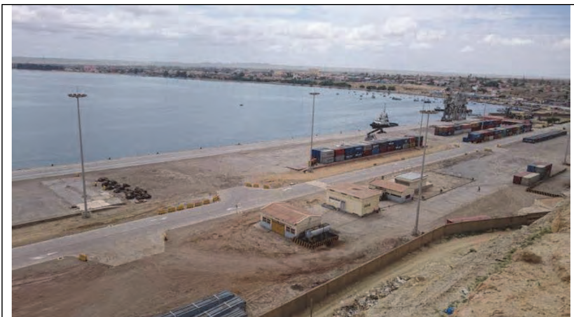
現況写真-1 ナミベ港 3B 岸壁全景
