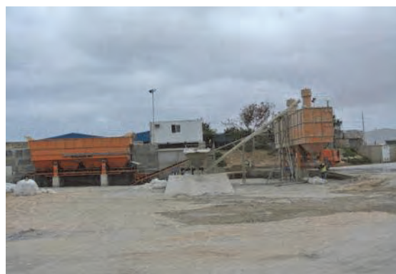
コンクリートプラント
