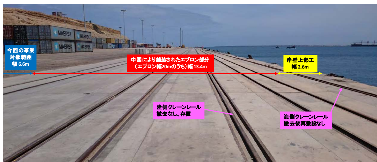
図 3.1 エプロンの舗装状況
