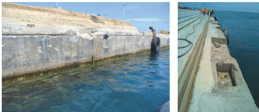
図 2.3 3B 岸壁上部工の状況
