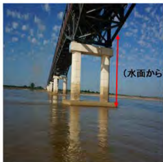
マンダレー周辺橋脚
