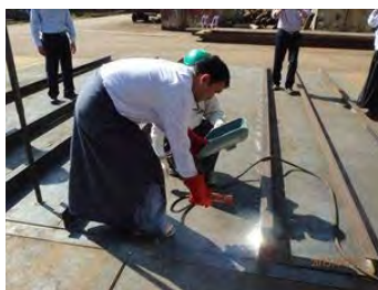
2015年4月 起工式 (各ブロック溶接)
