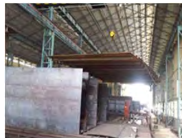
2015年5月 デッキプ レート接合
