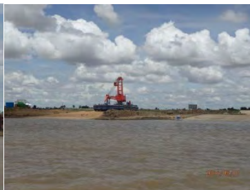
(シミコン港 250t クレーン)
