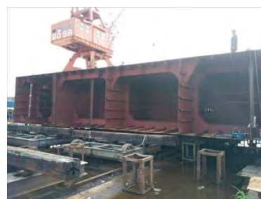
2015年9月 ブロック 接合完了
