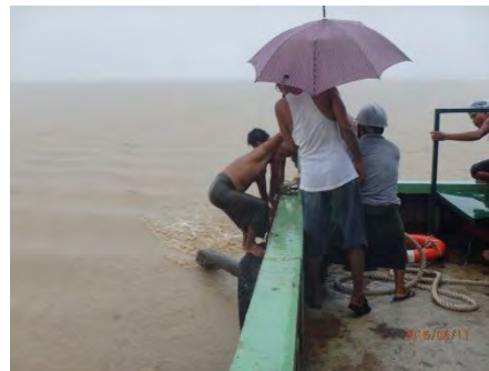
2016年6月ピー付近 増水後の流木撤去作業
