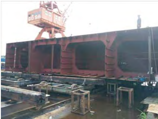
2015年9月 ブロック接合完了
