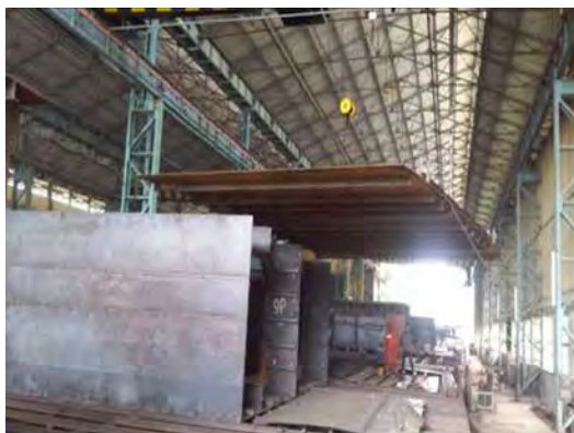
2015年5月 デッキプレート接合
