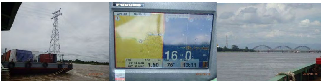
（ザガイン付近 高圧電線）
