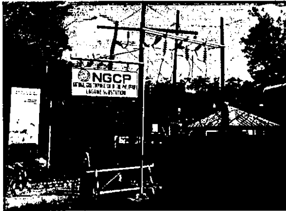
写真(1)変電所全景
