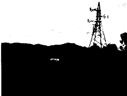
写真 6-3 既設の配電網設備①
