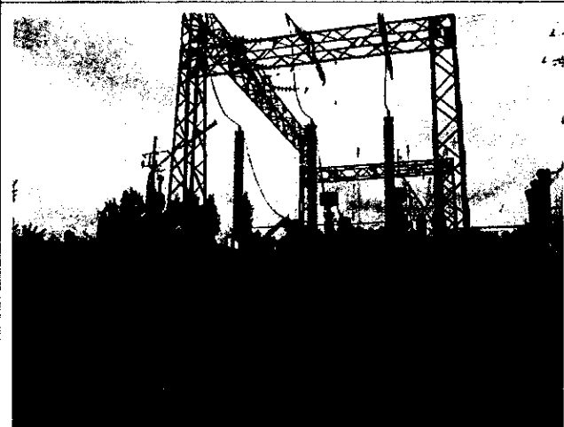
Musha 変電所（東部県 Rwamagana 地区） 既設 70/15kV 変電所（一次側電圧を 110kV に昇圧するため、 全設備を新規更新する） （2009 年 10 月 29 日撮影）
