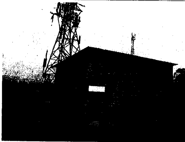
フイエ郡（ブタレ）配電網 更新対象である Ngoma 変電所（30/6.6kV, 1000kVA） （2009 年 10 月 30 日撮影）
