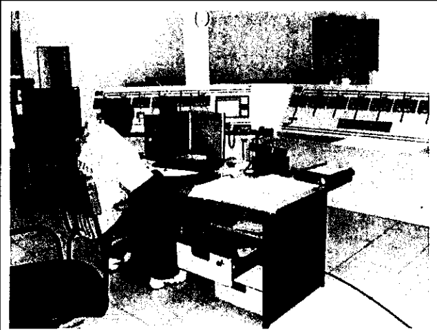
Gikondo 変電所（キガリ市 Kicukiro 地区） 2005 年に新規導入された中央制御装置 （2009 年 10 月 28 日撮影）
