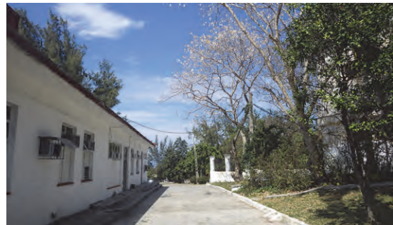
港湾・海岸環境技術センター実験棟
