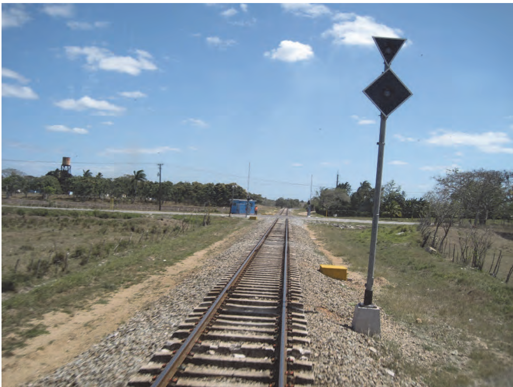
写真 2: 中央本線の線路状況 2
