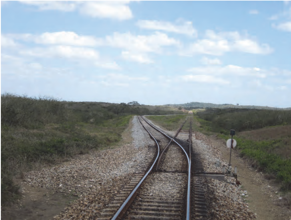
写真 1: 中央本線の線路状況 1
