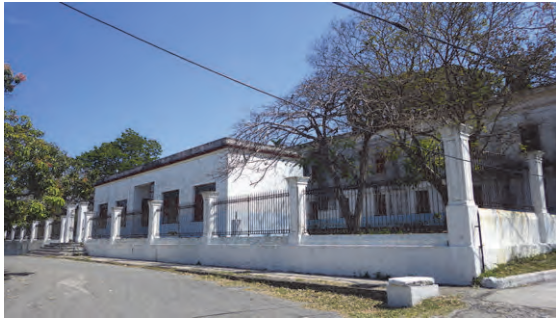
港湾・海岸環境技術センター外観
