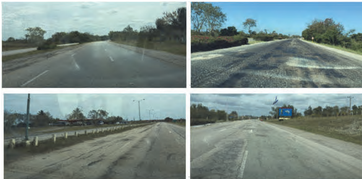
図 7-3 高速道路(Autopista)の路面状況
