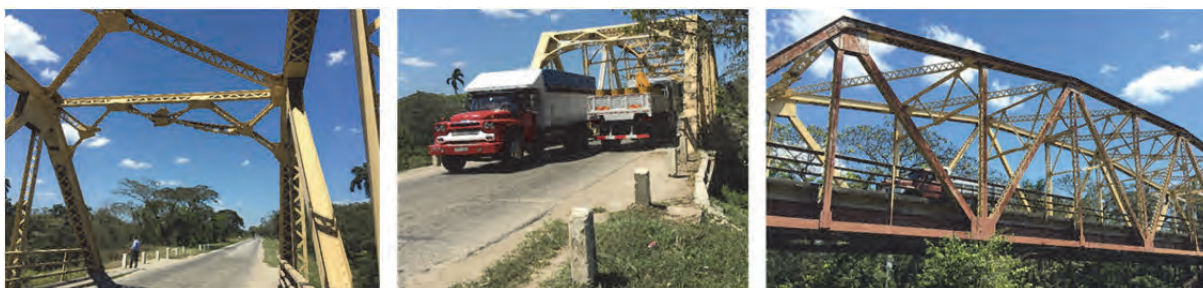
図 7-22 通過トラックによる損傷を受けた橋(サンティアゴ・デ・クーバ県マカリオ橋)
