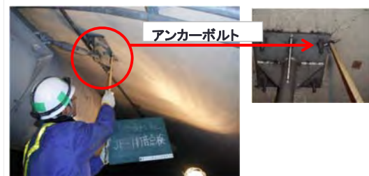
打音検査作業状況
