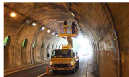
近接目視作業状況
