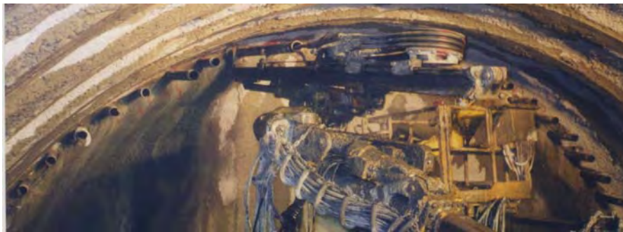
鋼管打設状況
