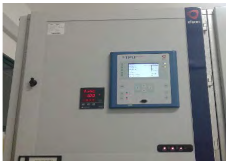
20kV Switchgear
