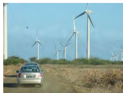
発電所構内道路状況
