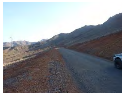
発電所構内道路状況
