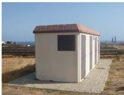
(b) 電源接続盤建屋 (PS)
