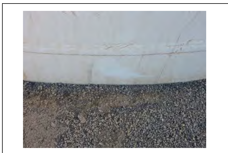
図 7.2-1 タワー下部補修状況 (Boa Vista)
