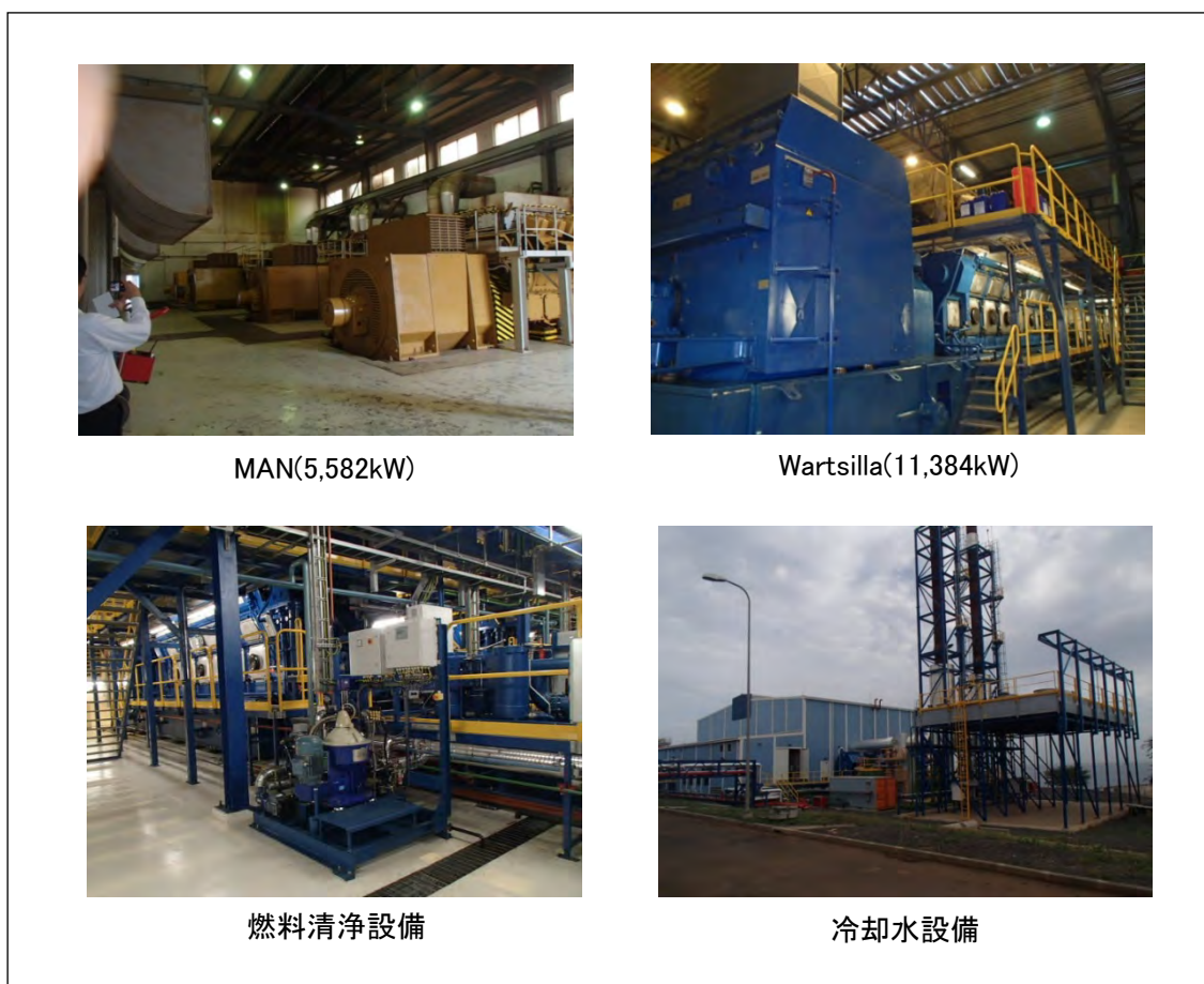
図 6.1-7 Santiago 島ディーゼル発電設備状況
