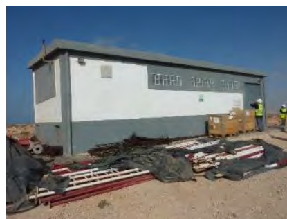
管理建屋(電気室)
