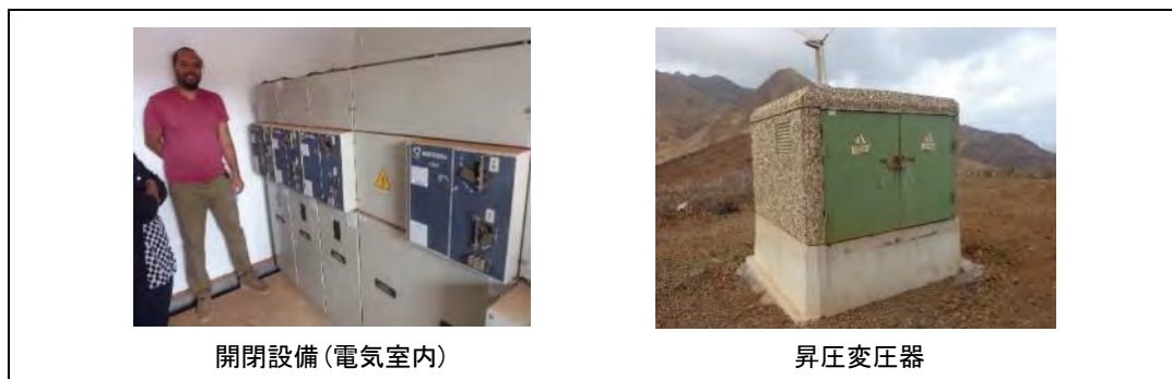
図 7.1-33 系統連系設備状況
