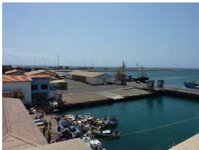
Praia 港岸壁状況
