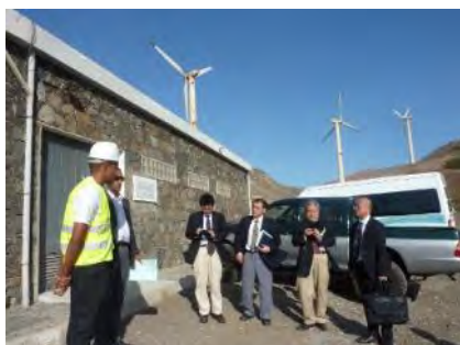
運転停止している Electra 設備 (Nordtank 製風車 × 3 基)
