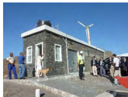
管理建屋(電気室)
