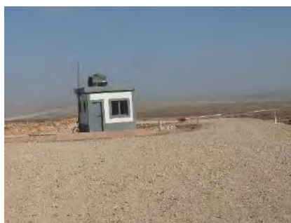
発電所構内入口守衛所および入口ゲート
