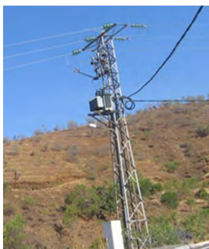
図 9.1-2 柱上設置変圧器 (PMT) と地上設置変圧器 (GMT)
