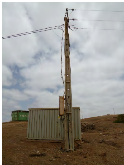
図 9.1-14 C. d. Tarefes の接続ポイント (定置型の 25 kVA 変圧器がコンテナ内に収納されている)
