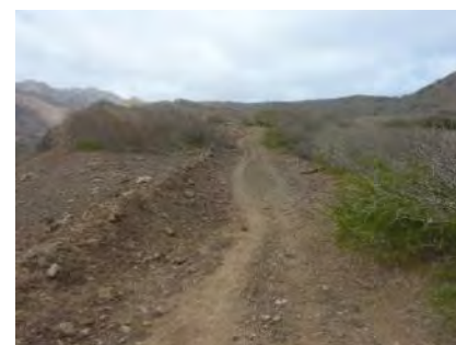
道路整備状況
