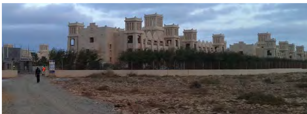
図 9.1-16 南部で建設工事中のリゾートホテル
