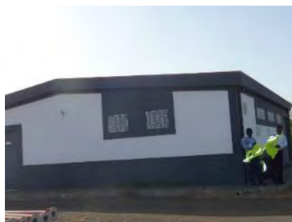
管理建屋（電気室）
