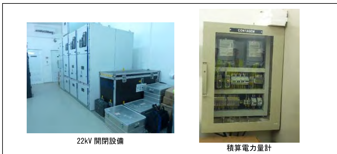
図 7.1-13 系統連系設備状況
