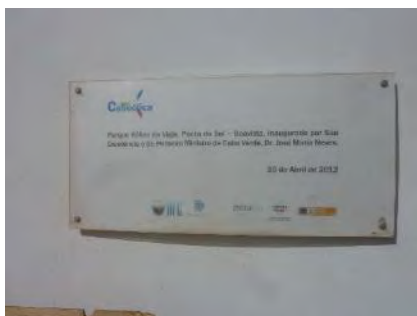
管理建屋設置の銘板 (2012年4月運転開始)
