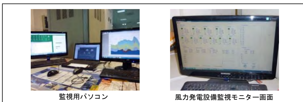
図7.1-18 Palmarejo 発電所の風力発電設備遠隔監視用パソコン
