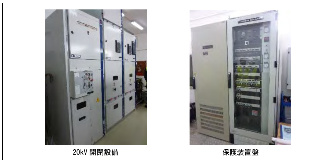
図 7.1-15 系統連系設備状況
