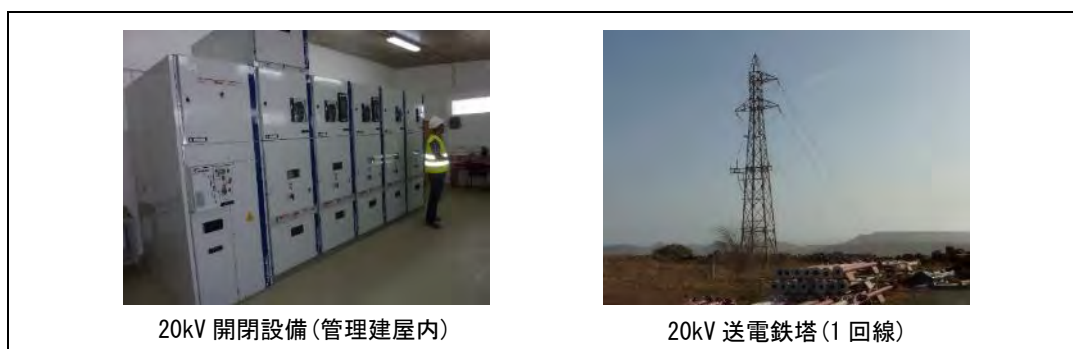
図 7.1-9 系統連系設備状況
