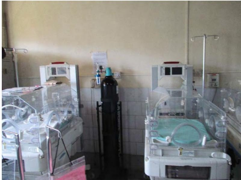
写真 3.5 転倒防止柵を設けて病室にシリンダーを配置した
