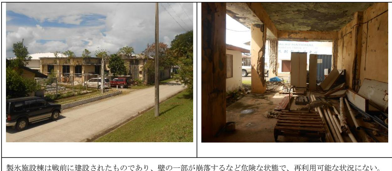
製氷施設棟は戦前に建設されたものであり、壁の一部が崩落するなど危険な状態で、再利用可能な状況にない。
