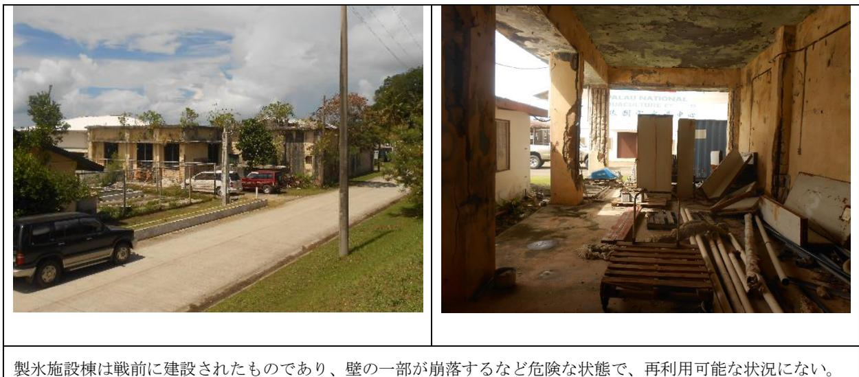
製氷施設棟は戦前に建設されたものであり、壁の一部が崩落するなど危険な状態で、再利用可能な状況にない。
