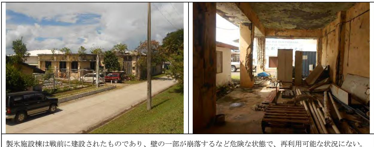
製氷施設棟は戦前に建設されたものであり、壁の一部が崩落するなど危険な状態で、再利用可能な状況にない。
