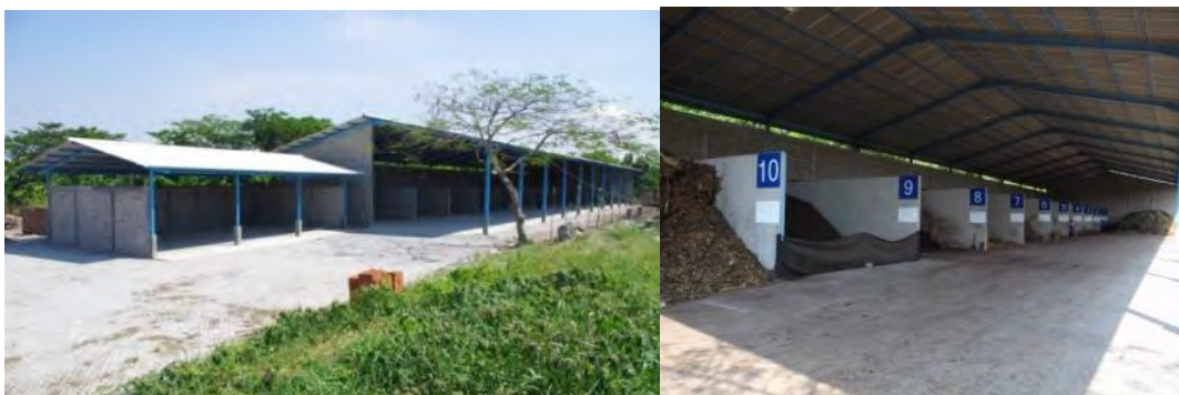
本事業の実証機材として、新規建設した堆肥化施設（2014年11月完成）
