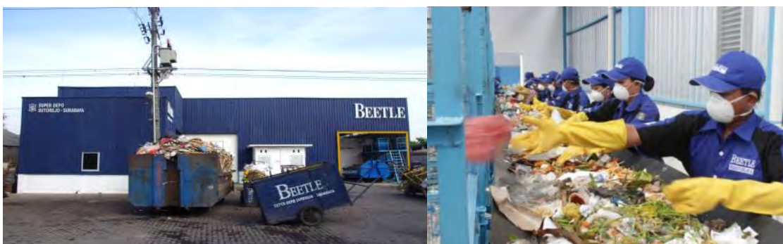
中間処理施設「Super Depo」
