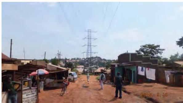
カワラ変電所 引込み鉄塔周辺の様子
