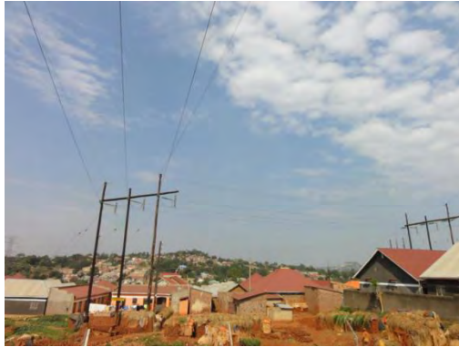
[備考] 左：132 kV 木柱引込ルート、右：No.570 分岐鉄塔 [出所] JICA 調査団
