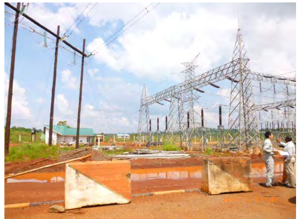
ブジャガリ変電所 変圧器増設予定地
