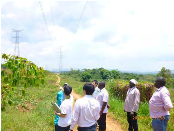
新ムコノ変電所への 220 kV 送電線引き込み予定地
