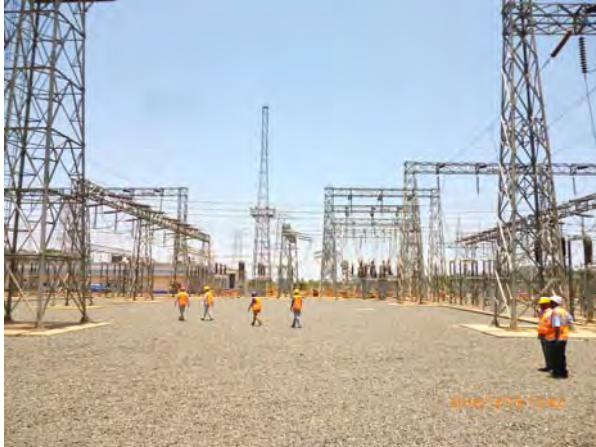
ブジャガリ変電所 132 kV 開閉設備増設予定地
