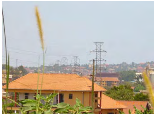
132 kV 送電線の状況 カンバラ北—ムトゥンドウエ回線
