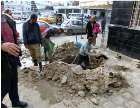
No. 61 街中の配水管漏水修理 (ビゼルト)
