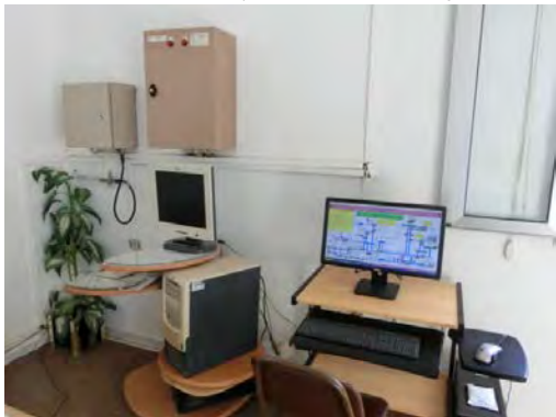
No. 29 メドニン生産局事務所のテレメーターシステム, PC による表示
