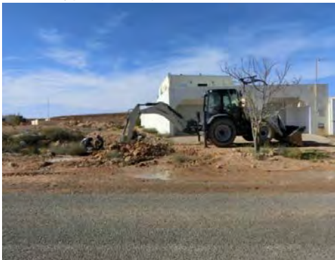
NO. 63 配水管漏水箇所確認のための掘削風景 (タタウィン)
