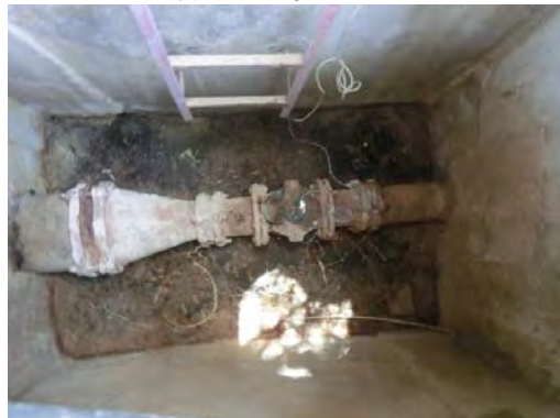
NO. 80 メドニン中心地区パイロットエリアの流量計 Qued Gharbaoui
