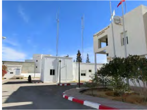
No. 28 メドニン生産局の遠隔監視・制御センター
