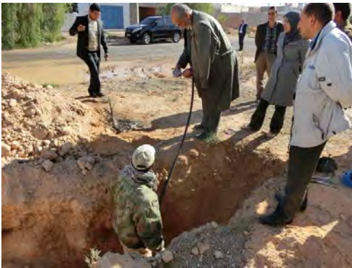
No. 23 配水管詰まり箇所発見のための圧力調査 タタウィン営業所
