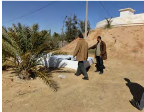
No. 58 配水タンク、流量計室 (ガベス)
