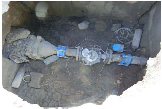
No. 40 配水管網内のセクター流量計に設置した 電磁流量計のデータロガー
