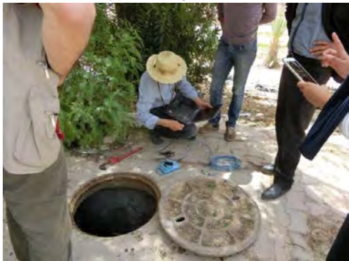
No. 79 メドニン中心地区 Qued Gharbaoui パイロットエリア候補地流入点の流量計
