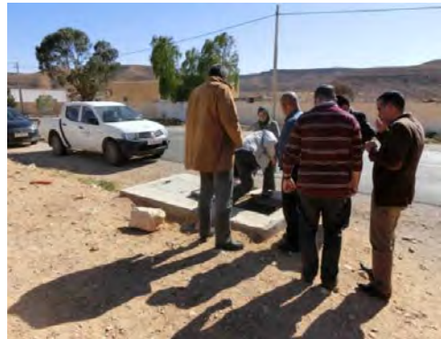
NO. 60 自動減圧弁ボックス (タタウィン)
