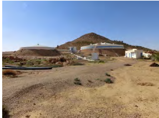
NO. 62 タタウィン配水タンク (5,000m 3 )
