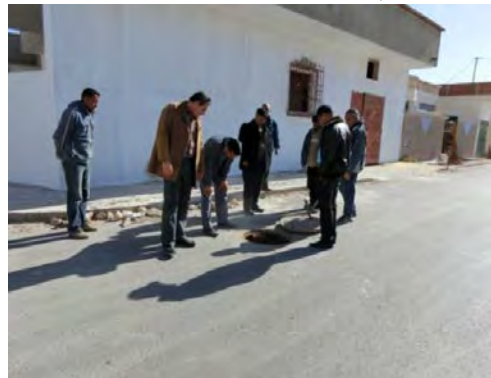
No. 64 バルブのマンホール (ガベス)
