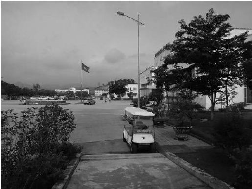
【写真 24:Lao Cai 省病院 中央が中央棟】
