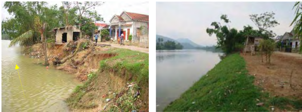
写真 3-4-1 クアンビン省における工事前後の河岸侵食状況（斜面防護＋水制 6 基）
