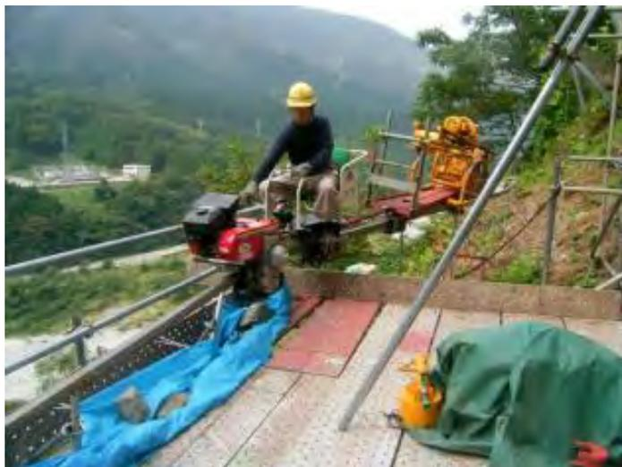
図 8 モノレールによる機材運搬
