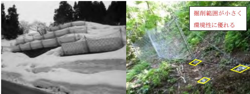
図 2 ARC-S 設置写真
