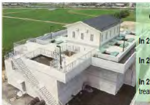
本城浄水場 上向流式生物接触ろ過池
