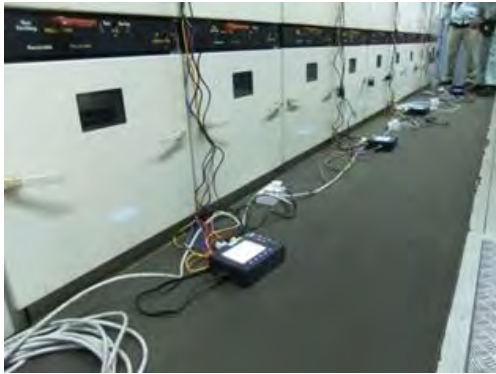
負荷遮断計測器設置状況 (Praslin 島)
