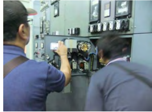
計測信号取り出し調査 (Praslin 島)
