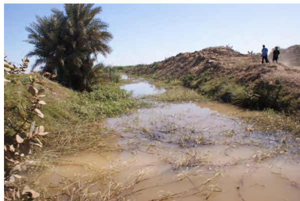
図 3-25 ゲジラ灌漑スキーム水路の堆砂
