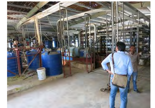
2/13 ポートスーダン海水淡水化施設 取水地点
