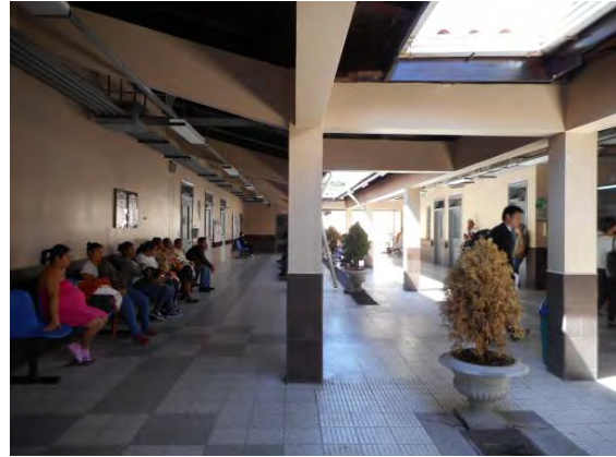
サンフェリペ病院 母子病院棟外観 維持管理がなされており、綺麗に使われている。
