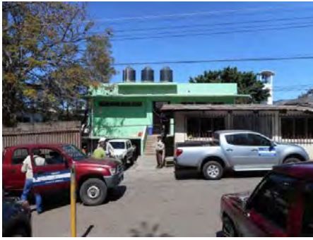
アロンソ・スワソ保健センター3階 既存の国立研究所 正面出入口 警備員が入口にいるだけで物理的な セキュリティは確保されていない。
