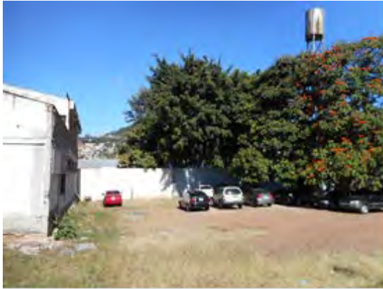
建設予定地 北方向 左は撤去予定建物。 敷地中央に高架水槽、高木がある。
