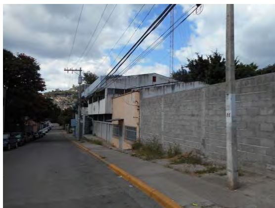
建設予定地 西側接道道路 コンクリートブロック造、2階建の撤去予定建物。
