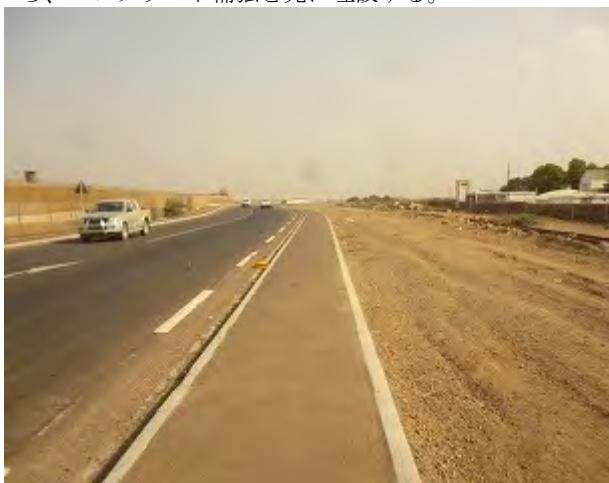
地中ケーブルルート(空港～ナガド地区)
