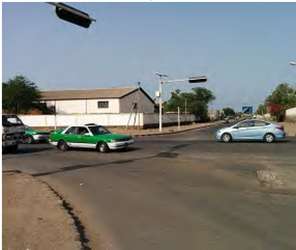
地中ケーブルルート(交差点)
