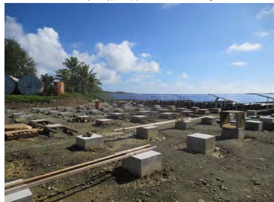
太陽光発電システムの据付状況 (撮影日：2015年1月18日)
