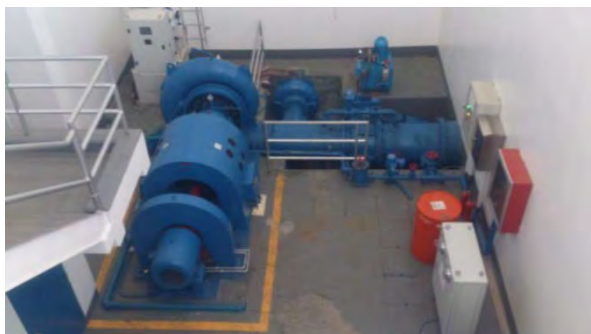
水力発電所の状況 (Nanpil Hydro)
