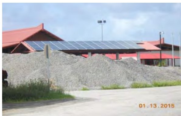
太陽光発電システムの据付状況
