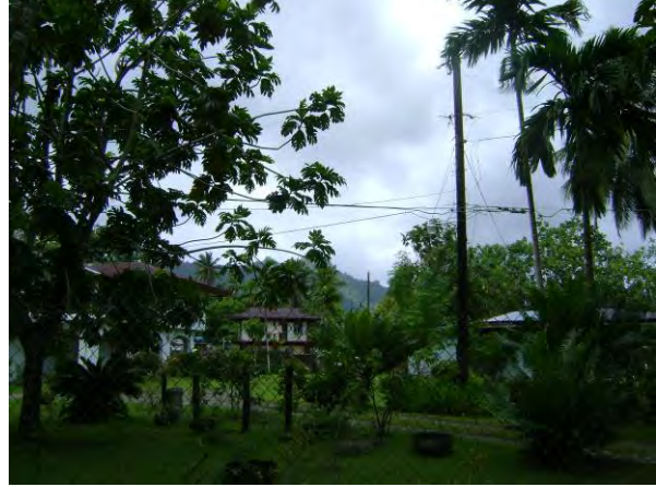
(民家の敷地内に電柱が立地)
