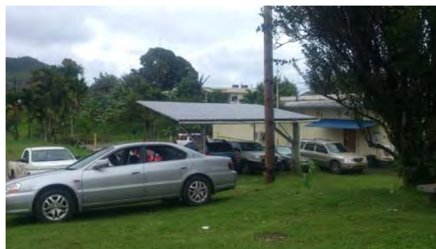
太陽光発電システムの据付状況
