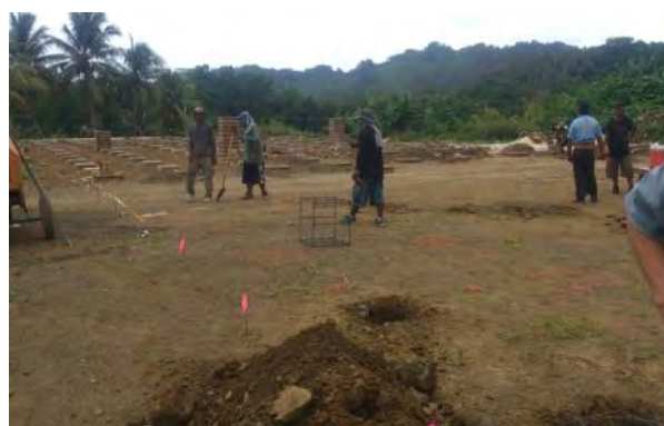
太陽光発電システムの基礎工事状況
