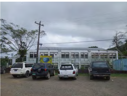
太陽光発電システムの状況 (Chuuk High School)
