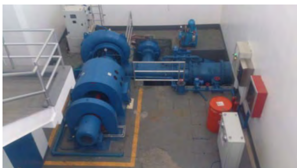
水力発電所の状況 (Nanpil Hydro)
