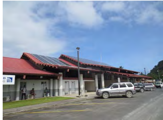
太陽光発電システムの状況 (空港)
