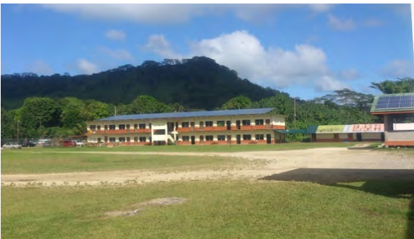
太陽光発電システムの状況 (Elementary School)
