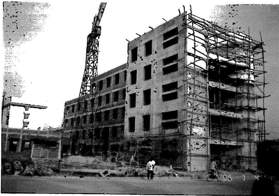
基建技校：建設中の事務棟 (今年中には完成予定)
