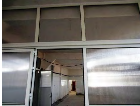
ONSSA 指導にて設置された仕切り（2016年5月調査団撮影）
