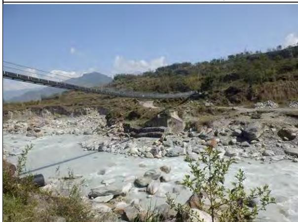
**写真 2-1-9 水管橋 HDPE 管φ400mm (1)**
