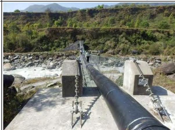
**写真 2-1-10 水管橋 HDPE 管φ400mm (2)**
