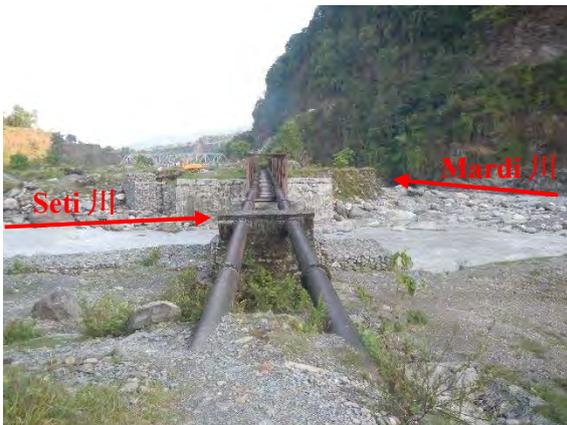
**写真-5：既設導水管の敷設状況①**
