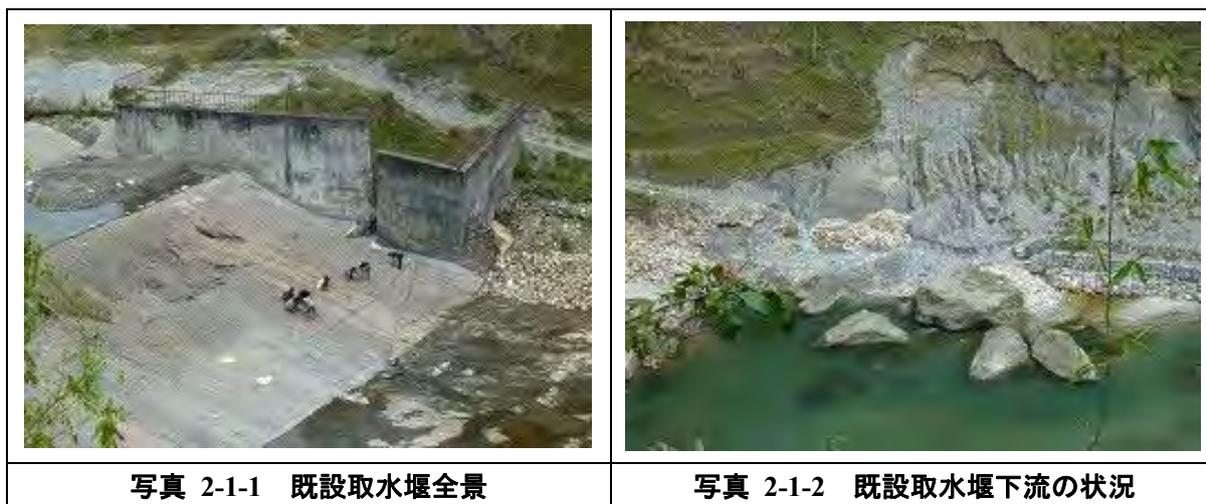
これらのことから、既設の取水堰は堰表面および護床を修復・整備することが望ましいと考えられる。これに対して NWSC は、本調査中の 2015 年に堰表面および護床に対して補修工事を実施した。
