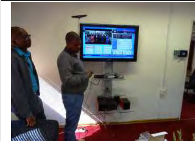
デモンストレーション用の受信機据付 (2015年6月)
