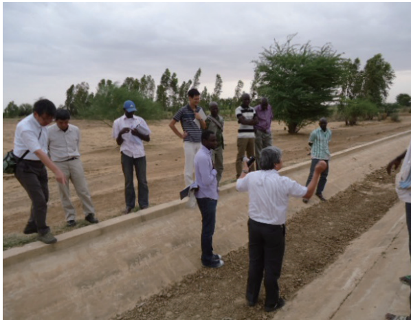
ポドール灌漑施設改善サイト
