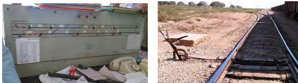
図 6-3 Bin Qasim 駅の暫定的な信号制御盤および手動式転てつ機
