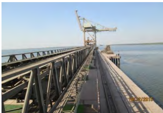
図 4-5 IOCB の栈橋とアンローダーとベルトコンベアー
