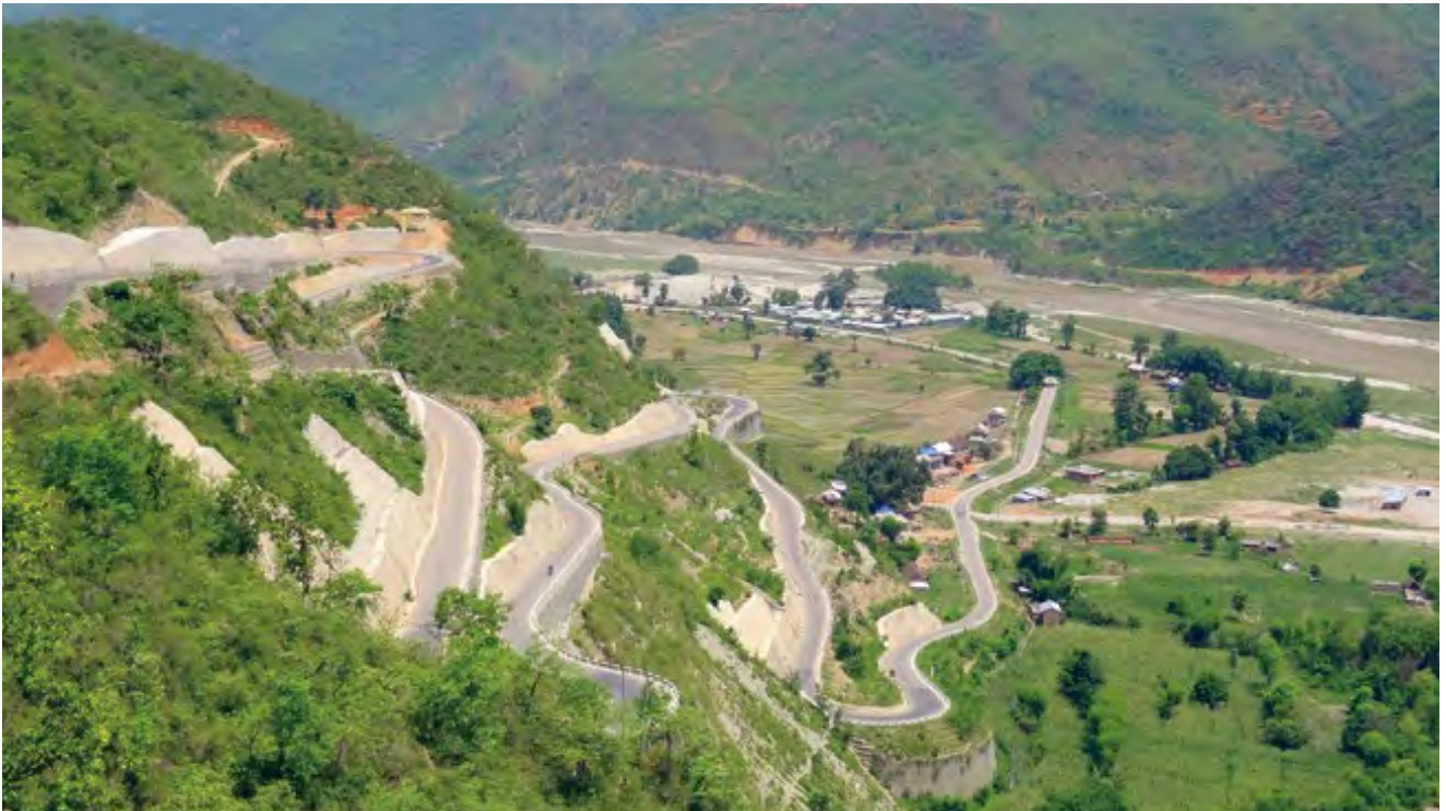
ネパールのシンズリ道路。無償資金協力により建設が進められ、1995年から約20年間をかけて完成した。2015年の大地震でも崩れず、救援物資の重要な輸送路となった
