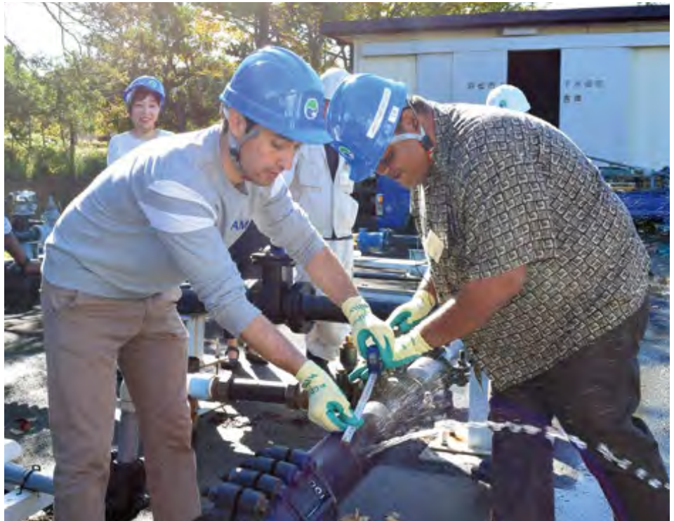
静岡県浜松市の研修施設で漏水の修繕技術を学ぶ研修員（課題別研修「上水道無収水量管理対策（漏水防止対策）」）
