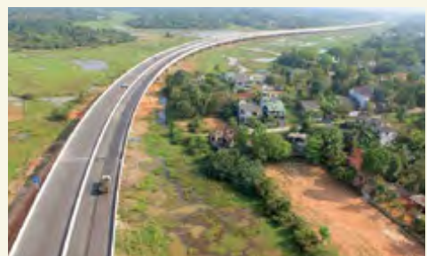
2015年9月の開通直前の外郭環状道路
