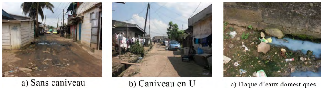
Figure 2-26 : Evacuation d'eaux dans la rue 2011
