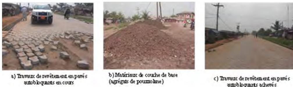
Figure 2-21 : Exemple de pose de revêtement
