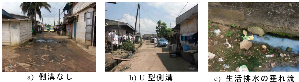
図 3-26：2011 通りの排水状況
