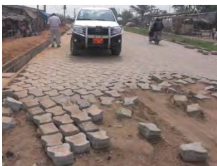
a) インターロッキングブロック舗装の施工中
