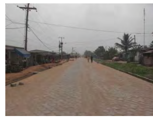
c) インターロッキングブロック舗装の完成
