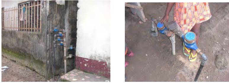
図 3-24：水道管の引き込み管
