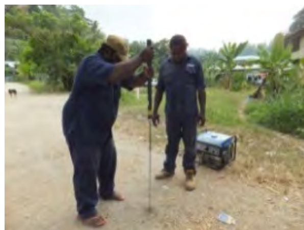
図 6.4-4 ハンマー・ドリルとボーリング・バーを利用した漏水調査
