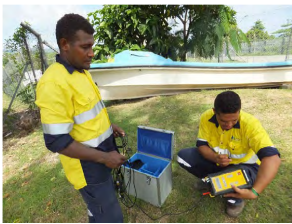
図 6.4-3 相關式漏水探知器を使った漏水ポイントの特定作業
