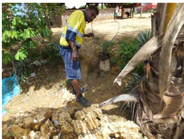
DMAにおける漏水探知
