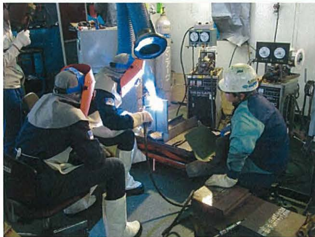
5月18日：片面溶接（立向）
