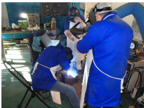
片面半自動溶接、下向溶接 ワイヤ：DW-100、裏当て材：FBB-3
