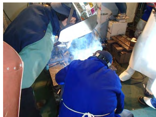
片面半自動溶接、水平溶接 ワイヤ：DW-100、裏当て材：FBB-3
