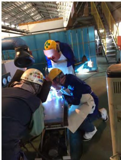
組立溶接（仮付）
