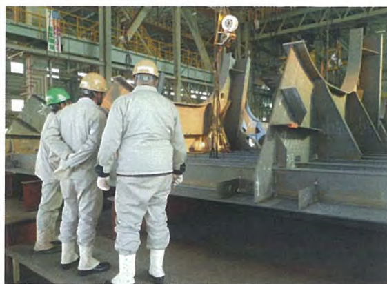
組立溶接工事の説明
