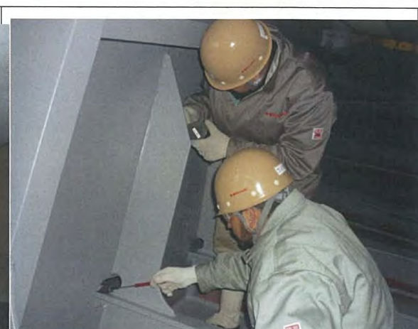
ブロック塗装完成検査
