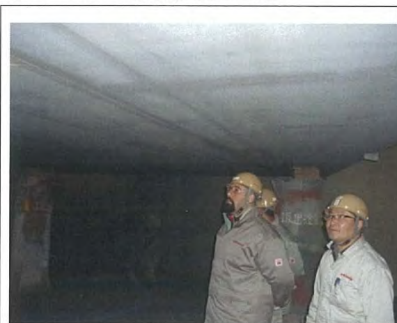
ブロック下地処理検査
