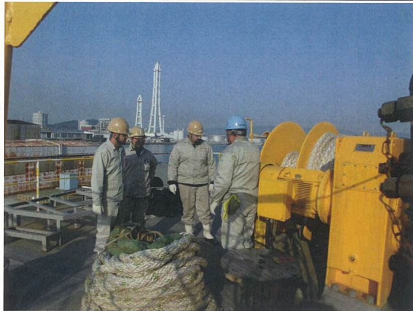
Winch の据付を説明
